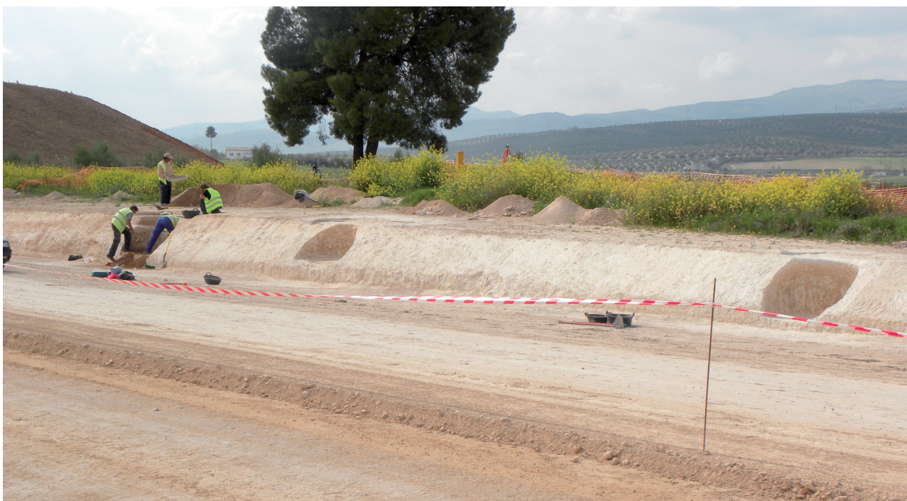
Lám. 2. Vista de la traza del AVE y de los trabajos de excavación.
